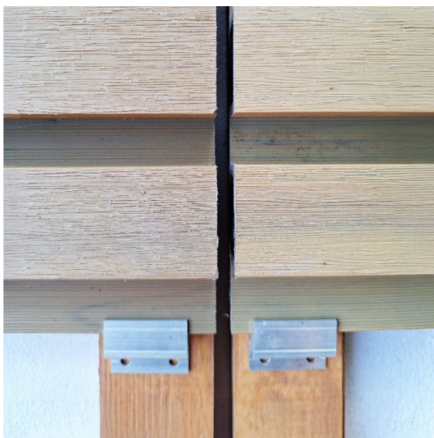
Zdjęcia. 7 i 8. Przykłady dodatkowego legara na łączeniach desek.
