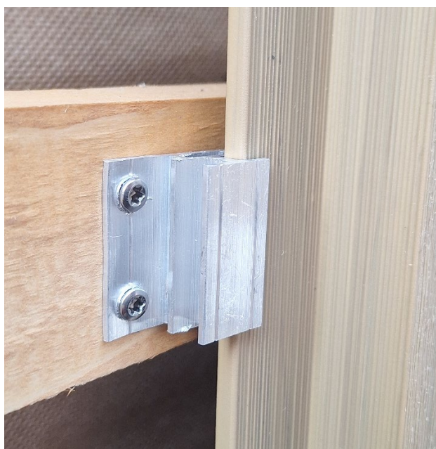
Zdjęcie. 4. Klips montażowy od strony pióra.
