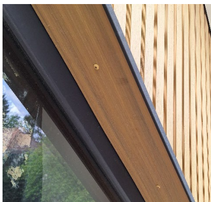
Zdjęcie. 13. Przykład okapnika nadokiennego.
