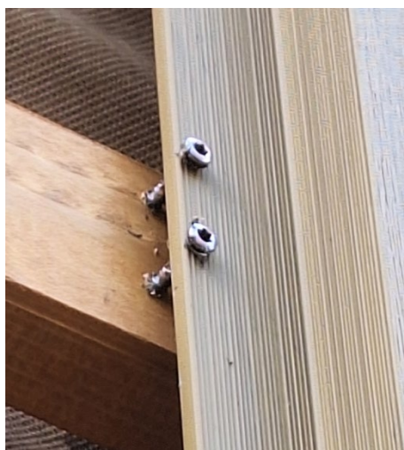
Zdjęcie. 6. Stały punkt montażu – z użyciem dwóch wkrętów na legar.
