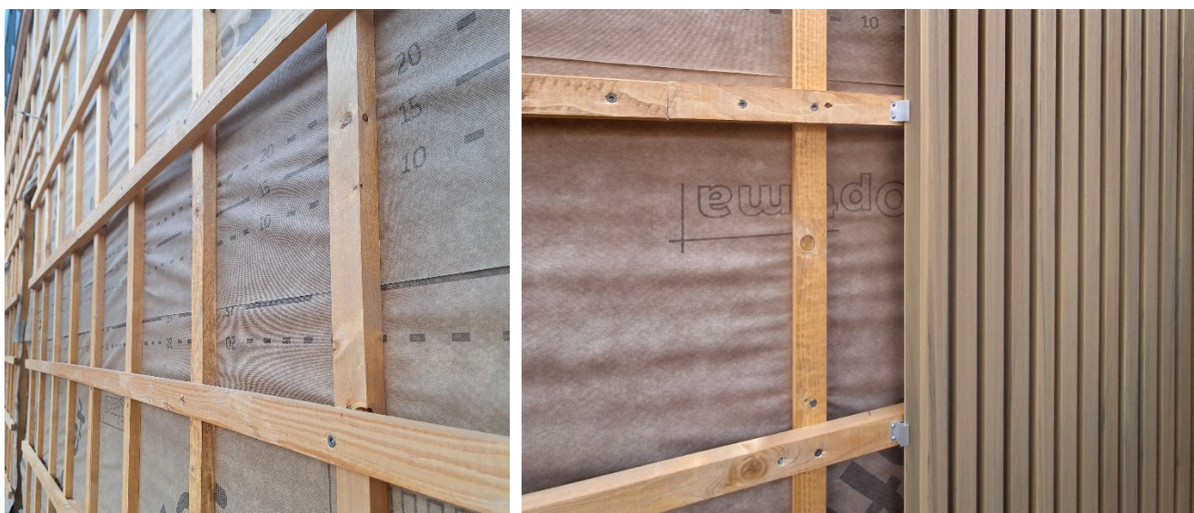
Zdjęcia. 1 i 2. Przykład rusztu montażowego krzyżowego z łąt drewnianych impregnowanych, do montażu desek Gardin Deco Wall pionowo.
